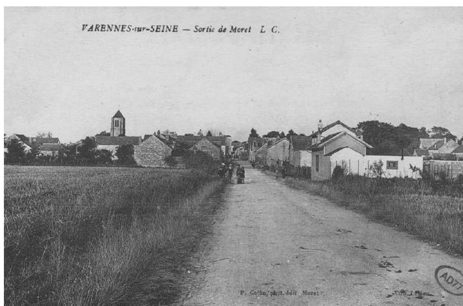
Entrée de bourg à l'Ouest avec vue sur l'église, état antérieur ©Archives Départementales de Seine-et-Marne
