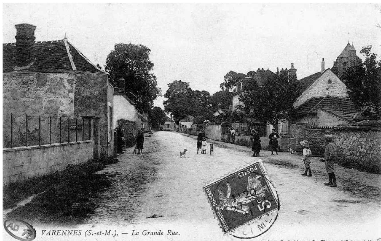
Grande Rue à l'Est de l'église, état antérieur ©Archives Départementales de Seine-et-Marne
