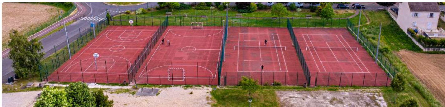
Les travaux concernent les deux terrains de droite
