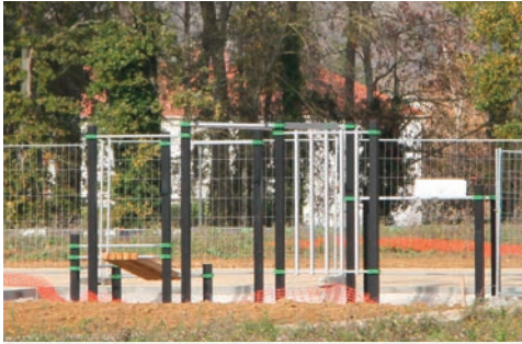
Installation d'une aire de fitness sur la Grande Garenne
