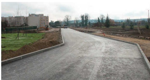
Nouvelle voie d'accès à l'école maternelle
